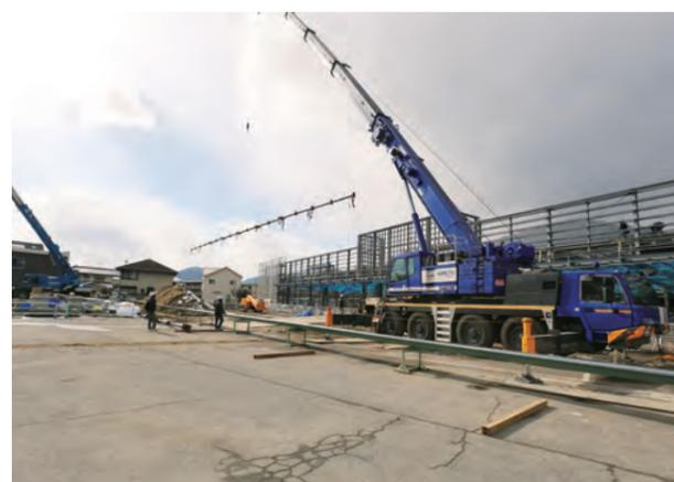
現場において成型機で成型した金属屋根をクレーンで吊り上げる様子
